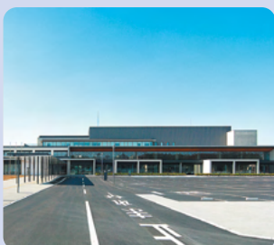
庁舎建設工事 (東武建設)
